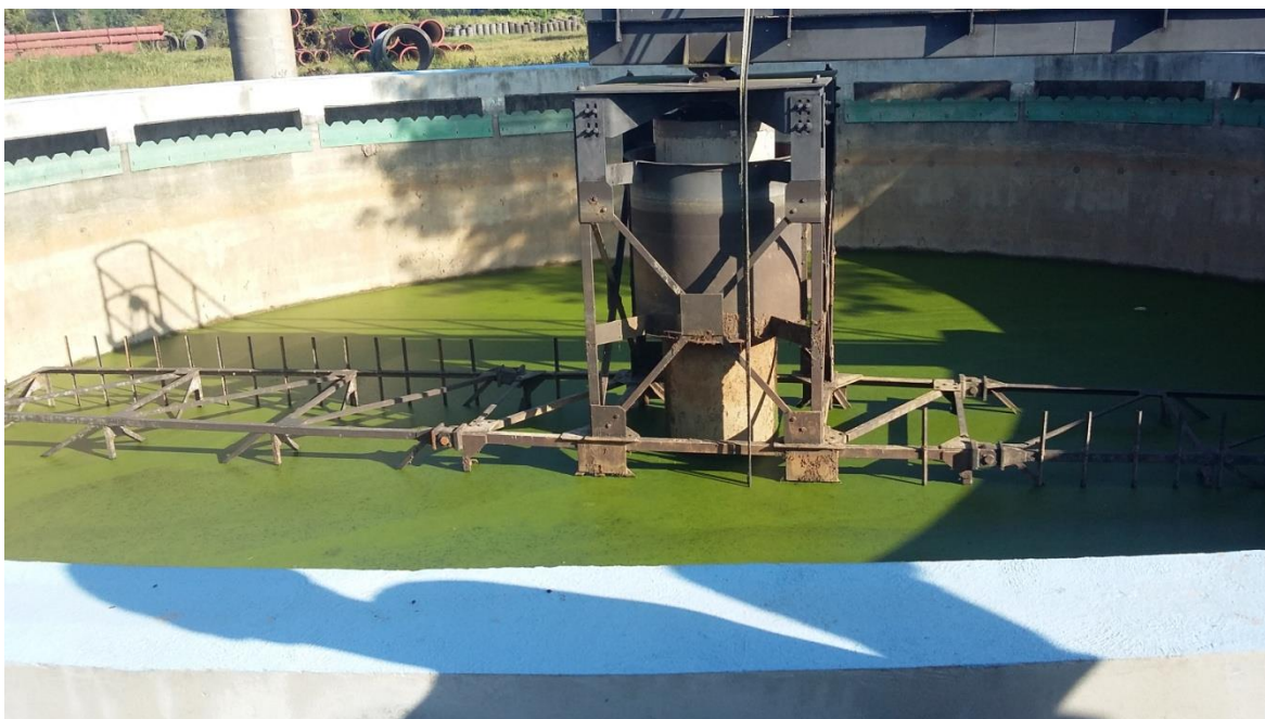
Imagem 8: Decantador em manutenção.
