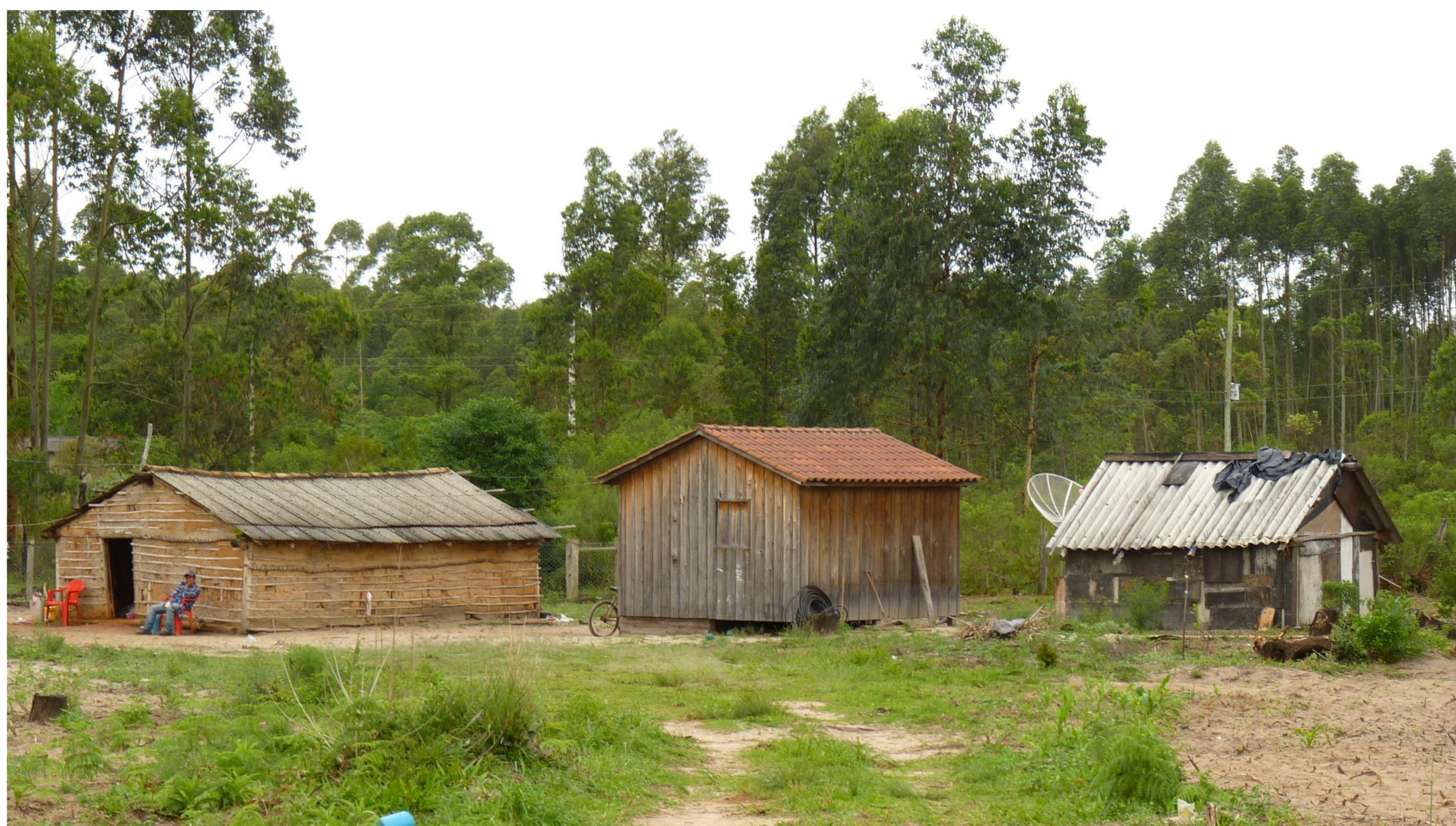
Conjunto de edificações (tradicionais e implantadas por programas assistenciais)
