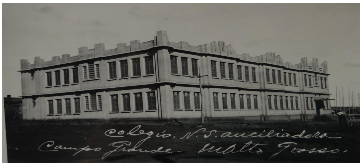
Imagem. 01 - Colégio Nossa Senhora Auxiliadora 1931, sede na rua Pedro Celestino Fonte: PENTEADO, Yara. Auxiliadora 70 anos: 1926- 1996. p.38.
