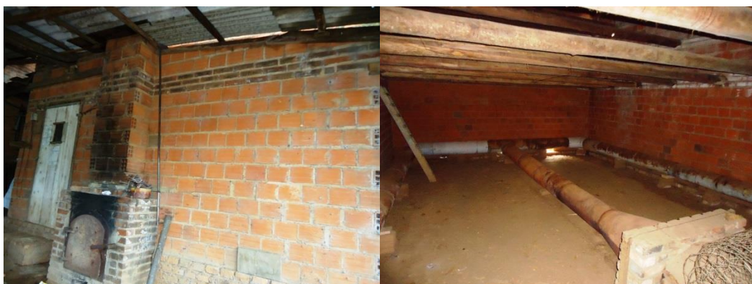
Figura 1: Estufa convencional: parte externa e interna
