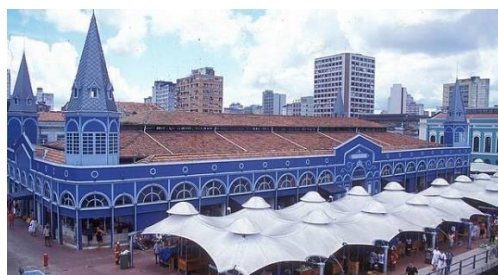
Figura 02: Fachada do Ver-o-Peso
